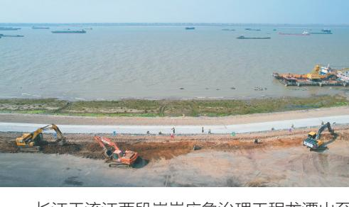
长江干流江西段崩岸应急治理工程龙潭山至包公山段正加紧完成水上护坡工程。新华社发
