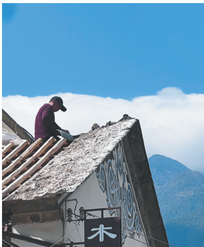
大理古城里，工人在修缮老民居屋顶。
