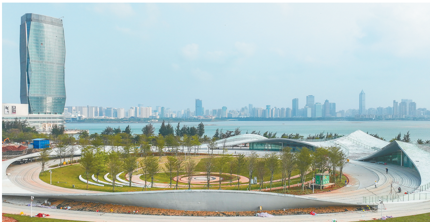
3月3日，航拍位于海口海甸岛美丽沙海岸西北处的海口湾“天空之山”驿站项目。本报记者 张茂 实习生 杨哲 摄
