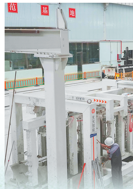
在位于临高县金牌港开发区的康庄住工装配式建筑部品海南生产基地，工人有条不紊地进行生产。 本报记者 陈元才 摄
