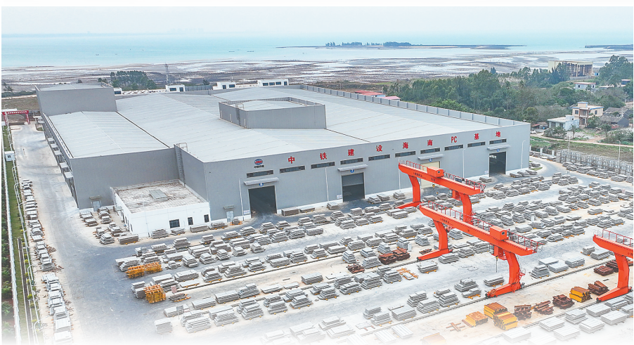
俯瞰中铁建设集团海南装配式建筑产业园。 本报记者 陈元才 摄
