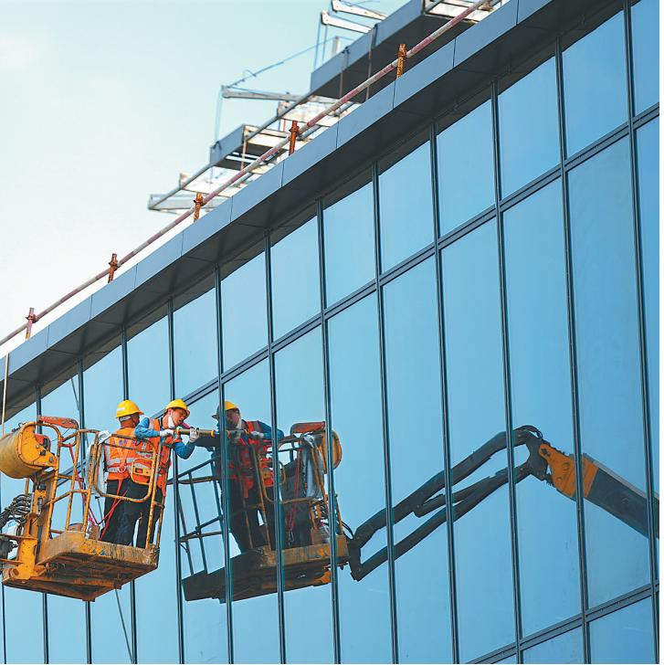
日前，位于海口江东新区总部经济区（生态CBD）的中银海南总部项目现场，工人正在进行幕墙施工。据了解，该项目总建筑面积约11.4万平方米，将打造成为海南自由贸易港的标杆性国际金融中心。
