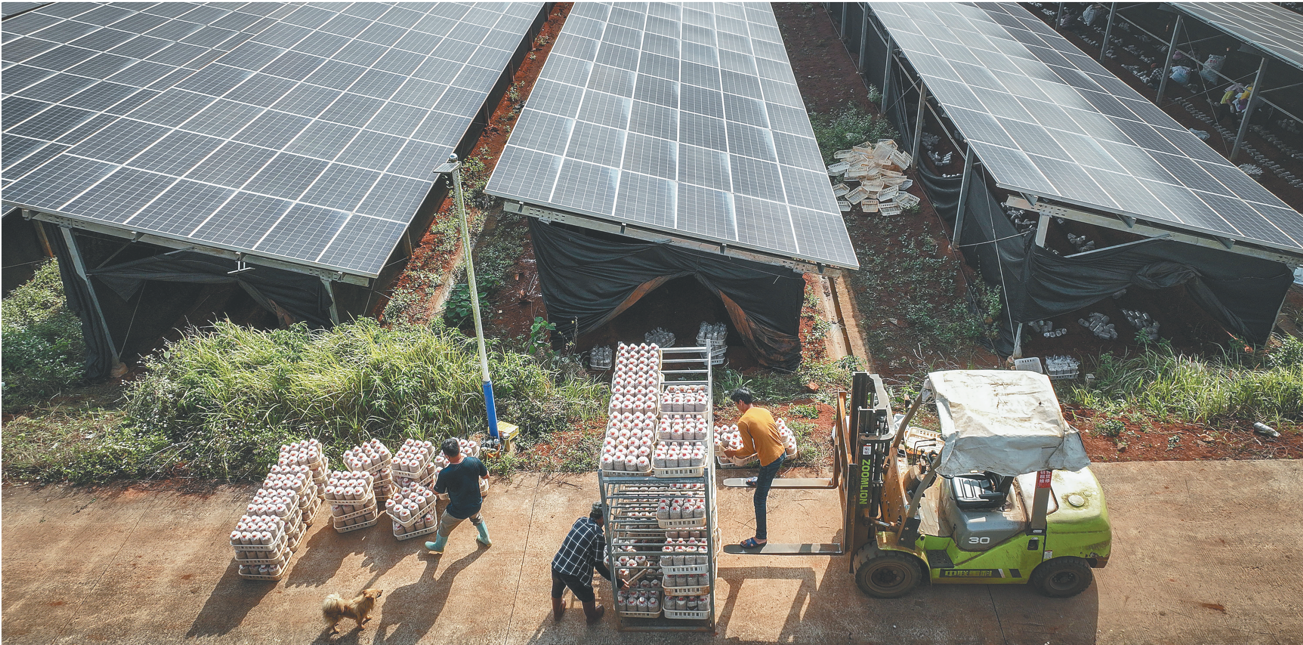
互补⑦ | 在海南省定安县“农光互补—光伏食用菌”项目基地,工人们齐心搬运蘑菇包,为在光伏下种植做足准备。基地将光伏电站和食用菌大棚建设合二为一,上可发电,下可种植,实现农光互补。
