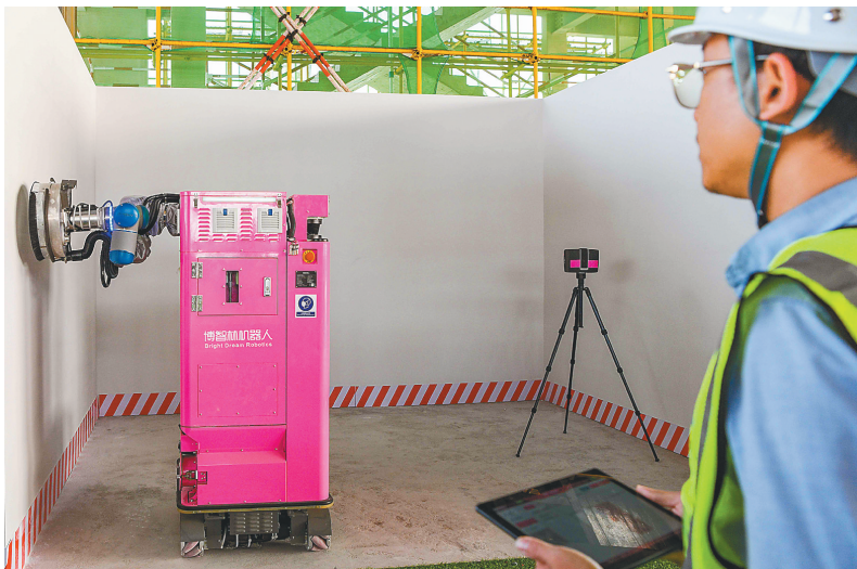
工作人员操作平板电脑指挥粉色的腻子打磨机器人作业。
