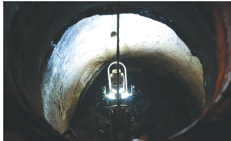
在三亚河东路月川段，管道检测机器人为排水管网“体检”。
