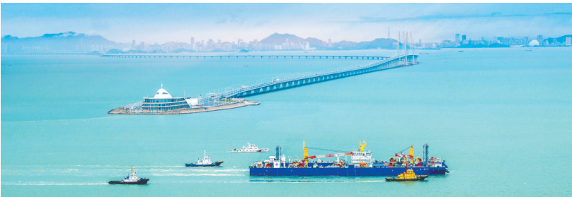
“一航津安1”号沉管运输安装一体船将E23管节和最终接头浮运至安装现场时经过港澳大桥。 新华社发
