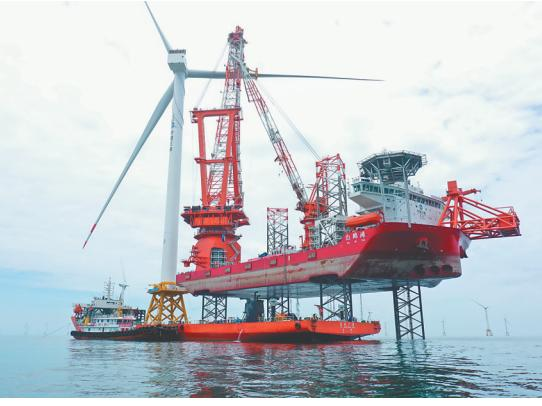
记者从中国三峡集团获悉，全球首台16兆瓦海上风电机组6月28日在福建北部海域顺利完成吊装。这标志着我国海上风电高端装备制造能力、深远海海上风电机组等全产业链实现整体提升，达到国际领先水平。
