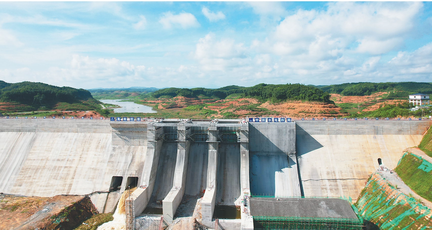
海南天角潭项目坝顶交通梁、门机梁全部吊装完成(分离图)大坝全线贯通。(海南天角潭项目部供图)
