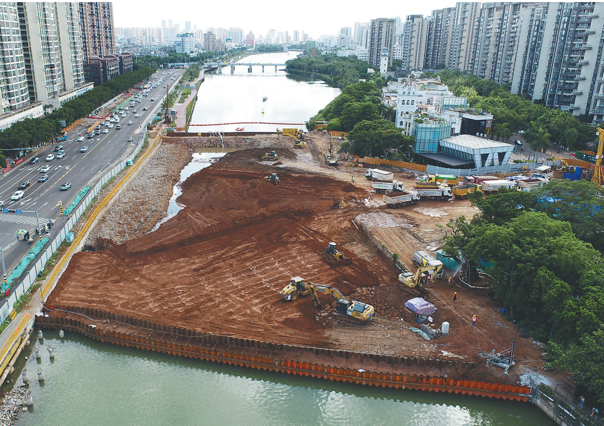
在海甸溪施工段，施工车辆正在进行围堰内部土方回填作业。（图片均由项目建设方供图）
