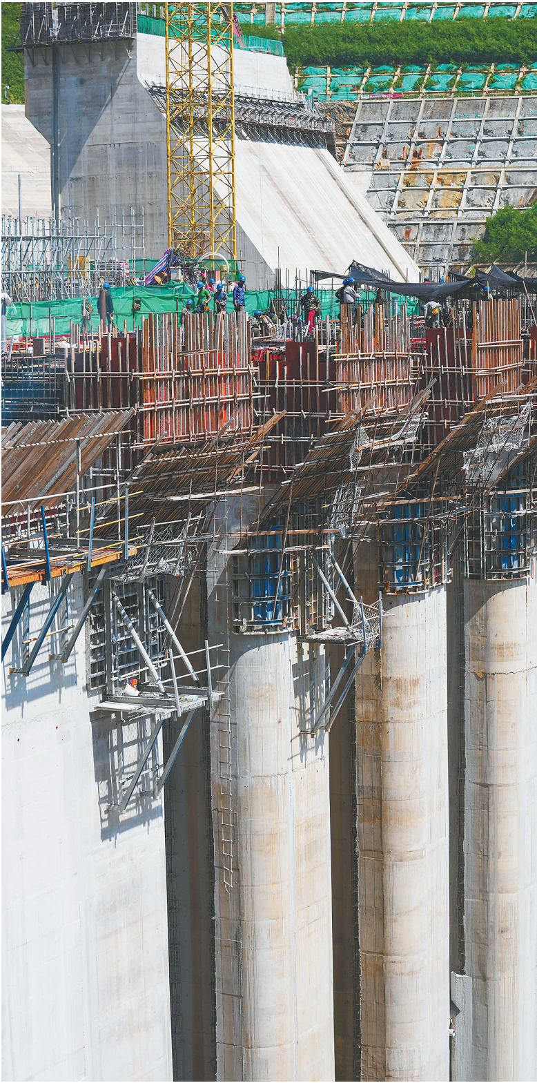
截至目前,迈湾水利枢纽工程项目主坝挡水坝段最高浇筑至111米高程。
