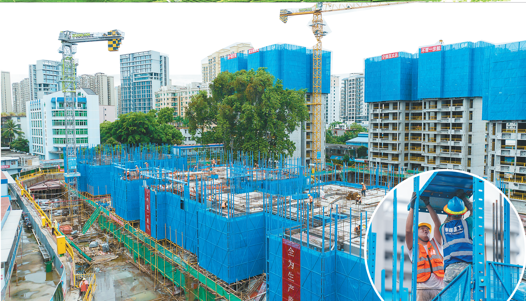
↑海垦·安悦兰亭安居房项目规整的蓝色钢爬架。 →近日，在海垦·安悦兰亭安居房项目现场，工人抓紧施工。本组图片由本报记者 袁琛 摄
