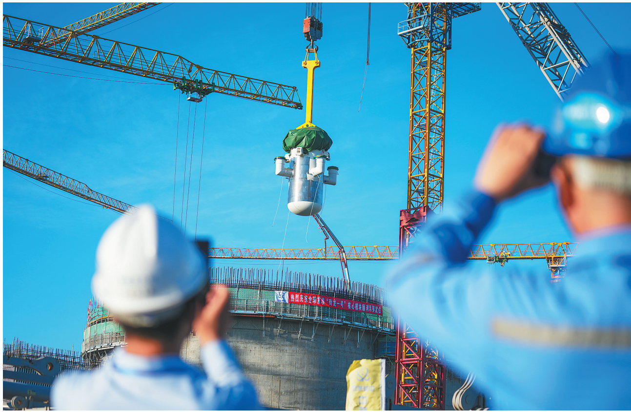
8月10日,“玲龙一号”反应堆核心模块吊装现场。
