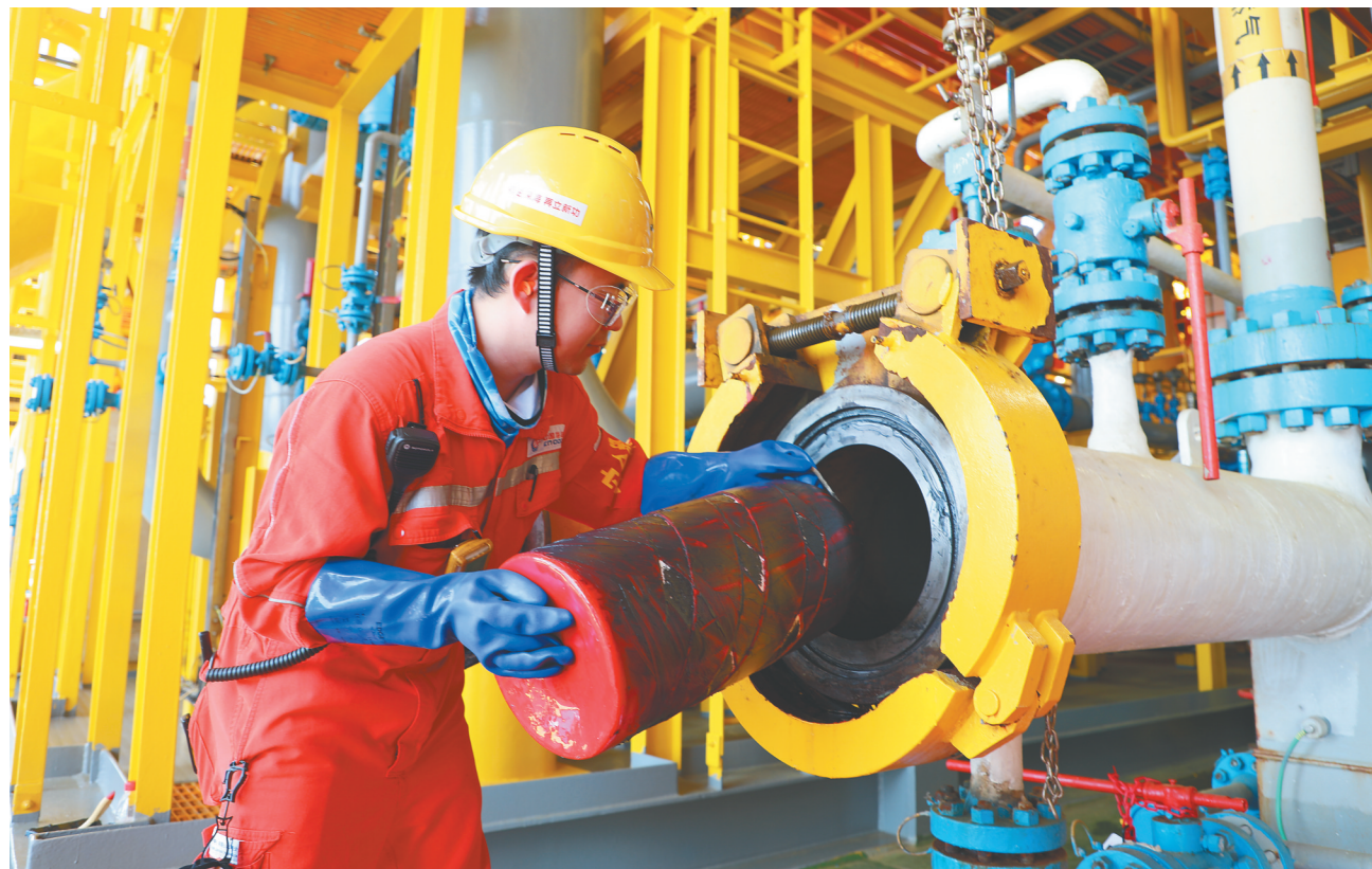
“深海一号”作业团队作业人员把清管球放入发球筒。 周宇 摄
