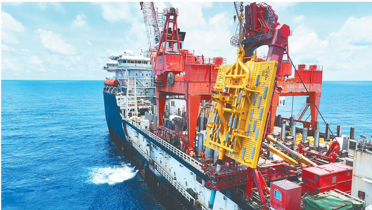
“海洋石油201”船正在进行海底管道终端安装。 宋艳磊 摄
