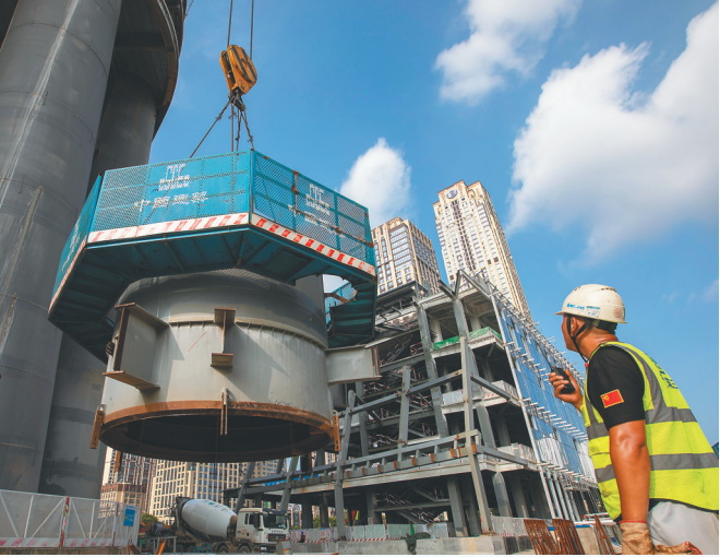
外框巨柱吊装加节
