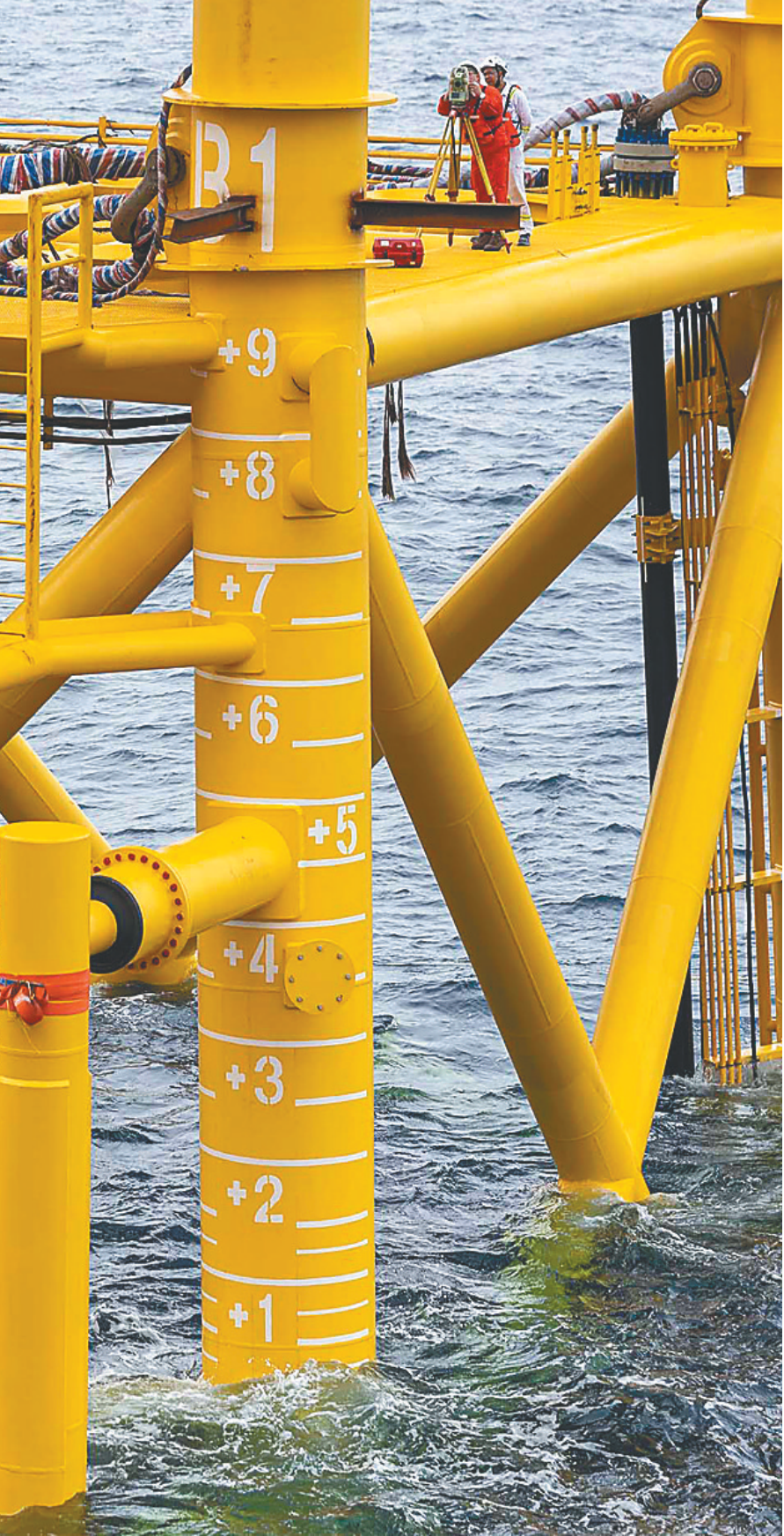
9月29日上午,项目技术人员正在测量导管架竖立海面后的水平度。
