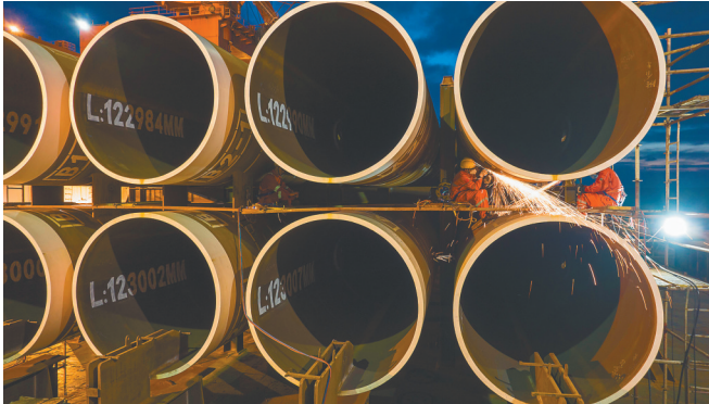
9月29日傍晚,电焊工人正在对钢桩支架进行拆解,这8根钢桩要打入海底固定导管架。
