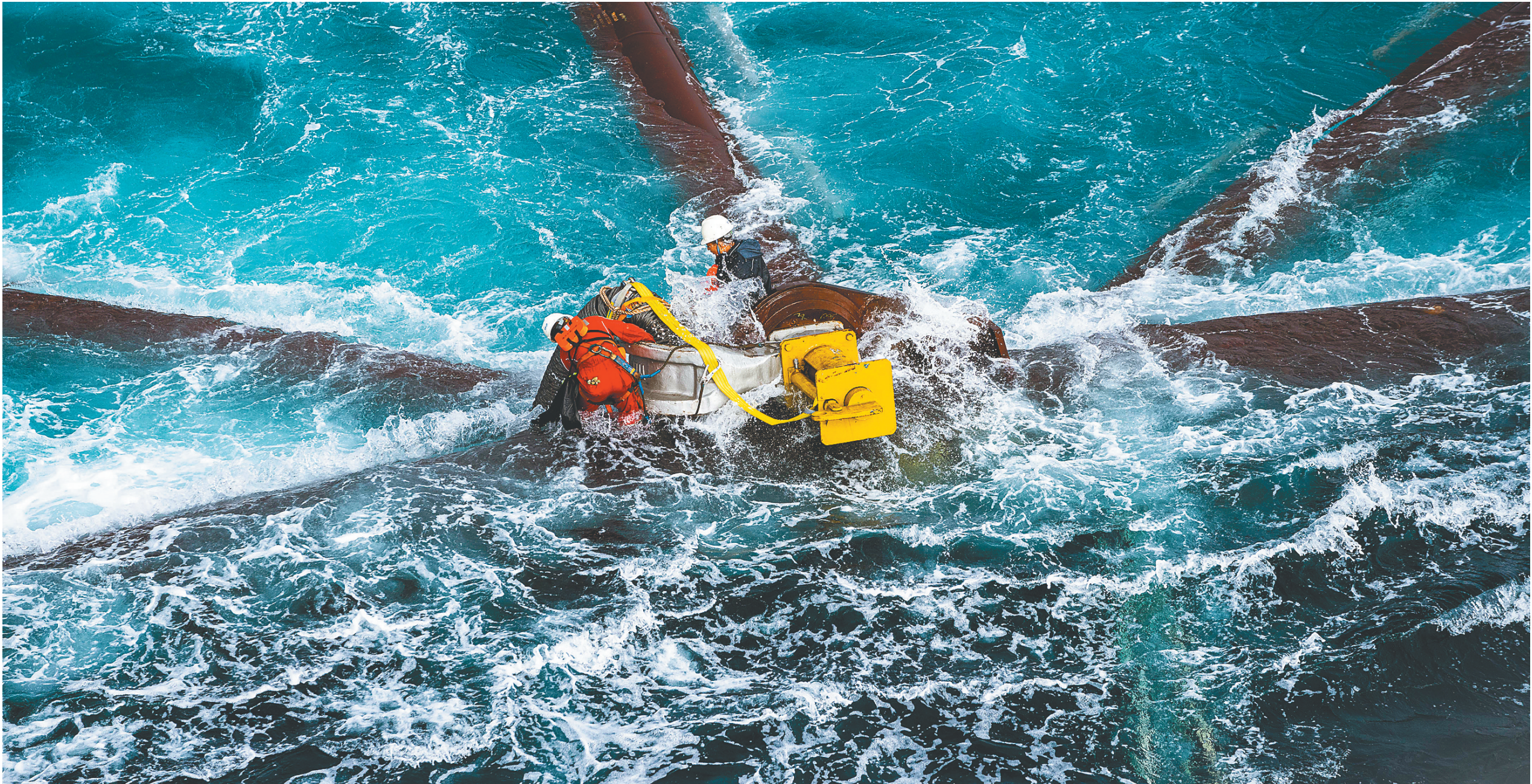
9月29日上午,项目技术人员正在测量导管架竖立海面后的水平度。
