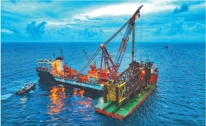
9月27日傍晚,“海洋石油201”号铺管起重船(左)正在对乐东10-1气田导管架开展起吊前的准备工作。
