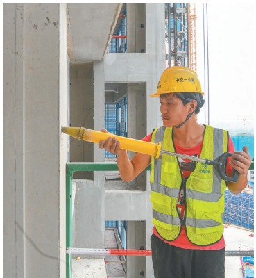
工人正在进行门窗施工。
