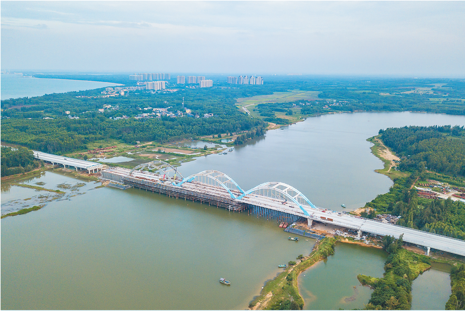
环岛旅游公路 临高段主线路基段已建成 10月14日拍摄的建设中的海南环岛旅游公路临高段文澜江大桥（无人机照片）。海南环岛旅游公路主线总里程988.2公里，串联沿途特色海湾、海角、特色小镇和旅游景区、滨海度假区等。海南环岛旅游公路临高段全长约58公里，目前主线路基段已建设完成，工人们正在对文澜江大桥进行桥面铺装、护栏、拱肋面漆喷涂等施工。 新华社记者 蒲晓旭 摄
