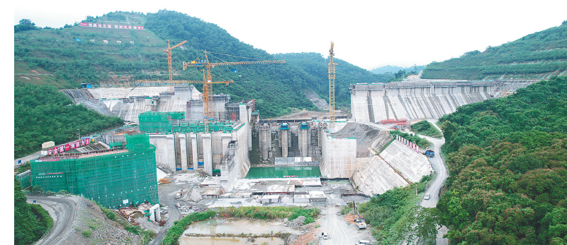
迈湾水利枢纽工程主坝建设现场。项目承建方供图
