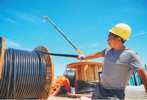
工作人员正在牵引电缆。这些电缆将被连接到每块光伏板，将绿电输送到千家万户。
