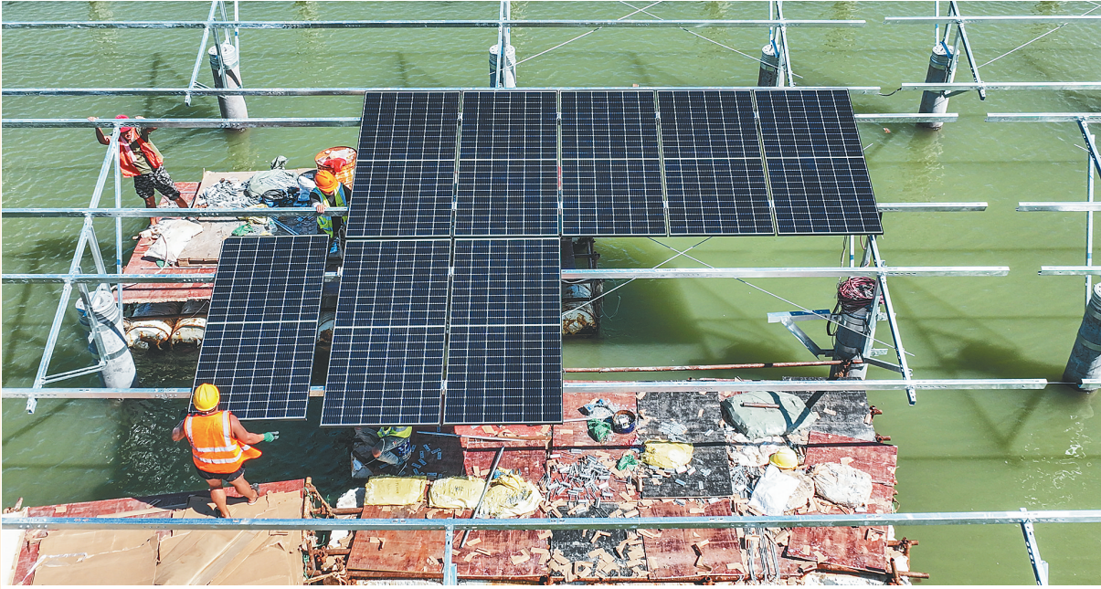
工人顶着烈日安装光伏组件。据不完全统计，施工人员每日能完成3636块光伏组件的安装工作。
