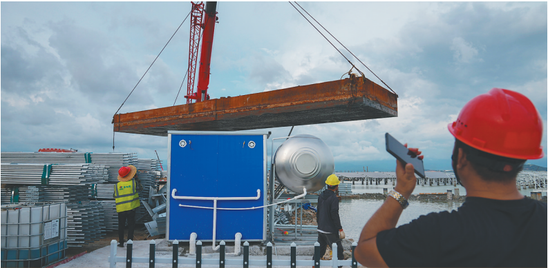
工人通过吊装作业将运输浮船从陆地转移到湖中。运输浮船能通过水运将工人和物料送达目的地。
