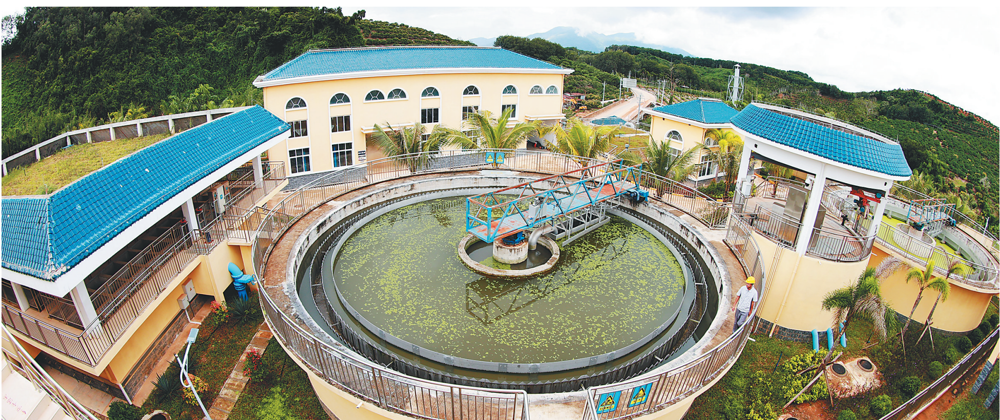
近日，由三亚环投集团下属创新新城污水处理有限公司运营的污水厂——三亚育才水质净化厂正式投入试运行，实现了对育才生态区的污水收集处理，为三亚水环境保护再添保障，助力“六水共治”。育才水质净化厂位于育才生态区城区西北角，占地面积约16.5亩，设计规模为每日处理0.25万吨。目前试运行阶段出水状况良好，经处理后的尾水将用于市政回用、农业灌溉和储水备用。
