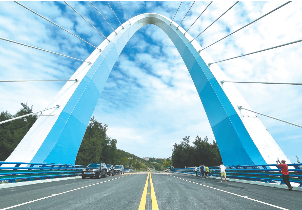
万宁龙滚河大桥是海南环岛旅游公路万宁段的控制性工程,为我省首座无背索斜拉桥。图为十一月一日拍摄的万宁龙滚河大桥。 本报记者 曹马志 摄
