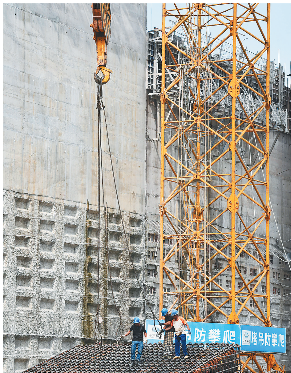
10月31日,迈湾水利枢纽工程施工现场。
