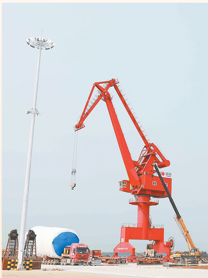
临高金牌港开发区东作业区西码头。三石 摄
