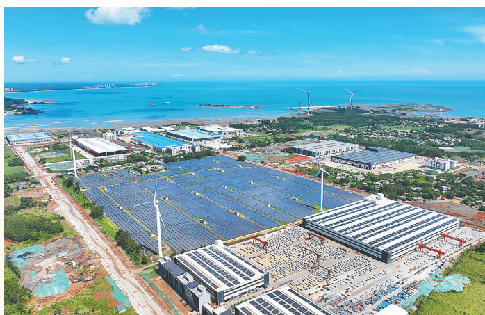
航拍临高县金牌港园区钢构项目。 临高县融媒体中心供图
