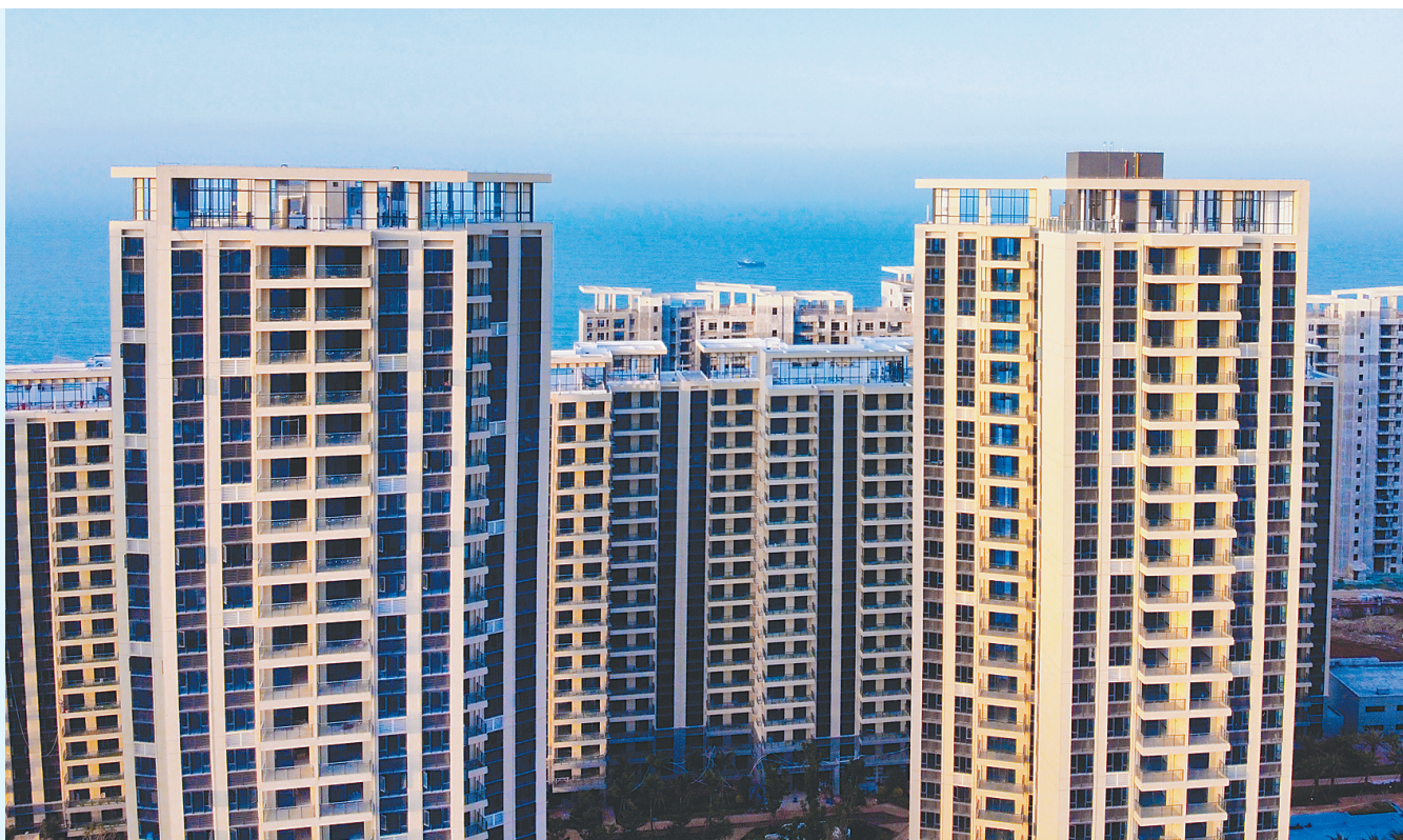
海口碧桂园中央半岛海辰府项目实景。
