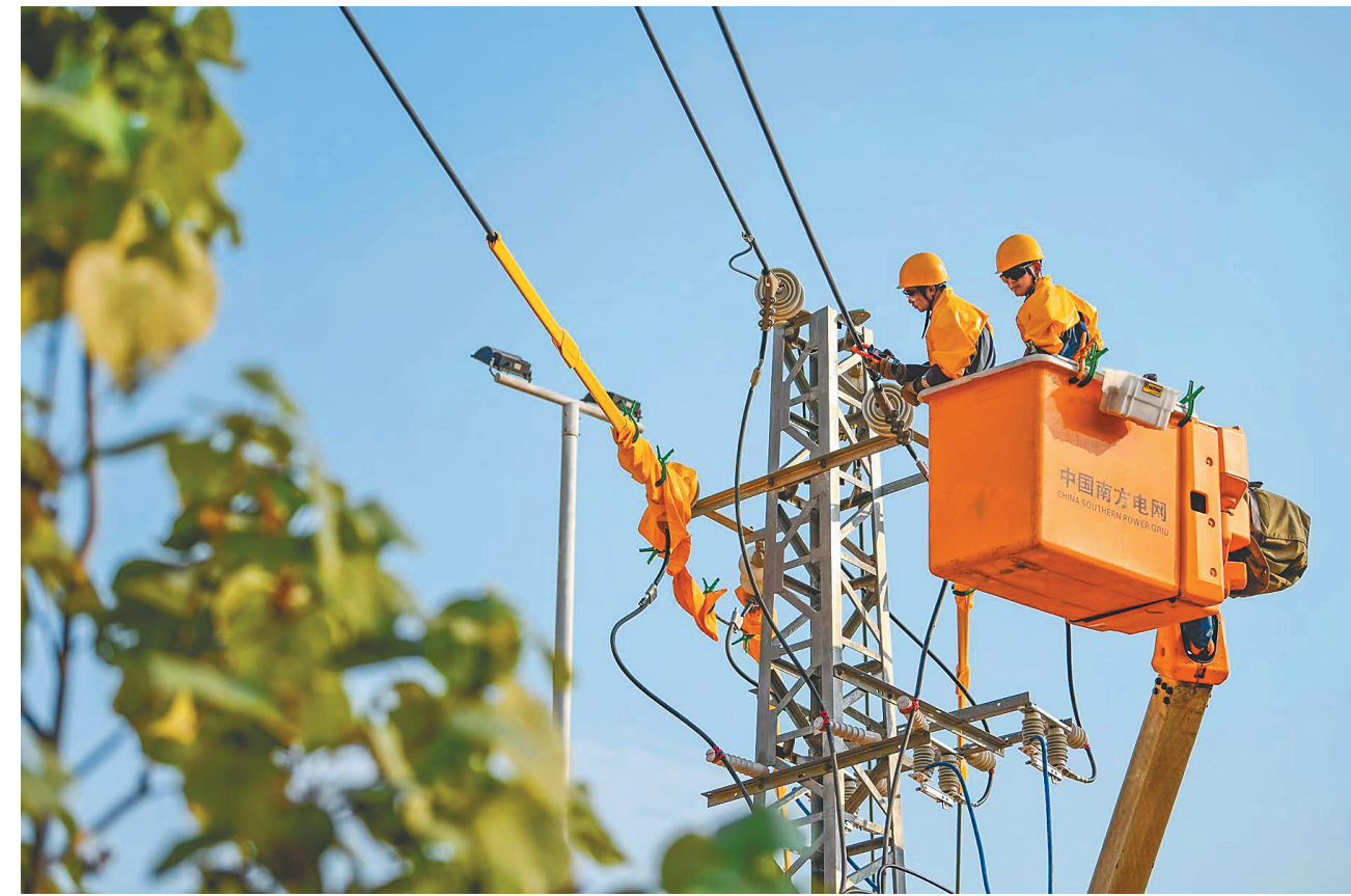
南方电网海南电网公司工作人员开展带电作业，提高供电可靠性。本组图片均由 杨永光 摄
