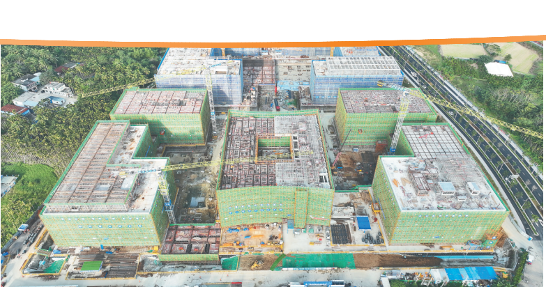
建设中的乐城医工转化平台。（项目建设单位供图）
