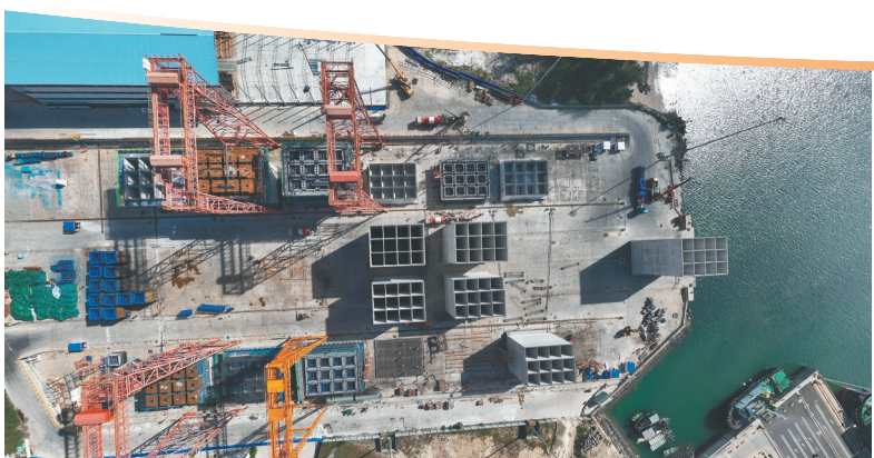
航拍洋浦区域国际集装箱枢纽港扩建工程沉箱预制场。（项目建设单位供图）
