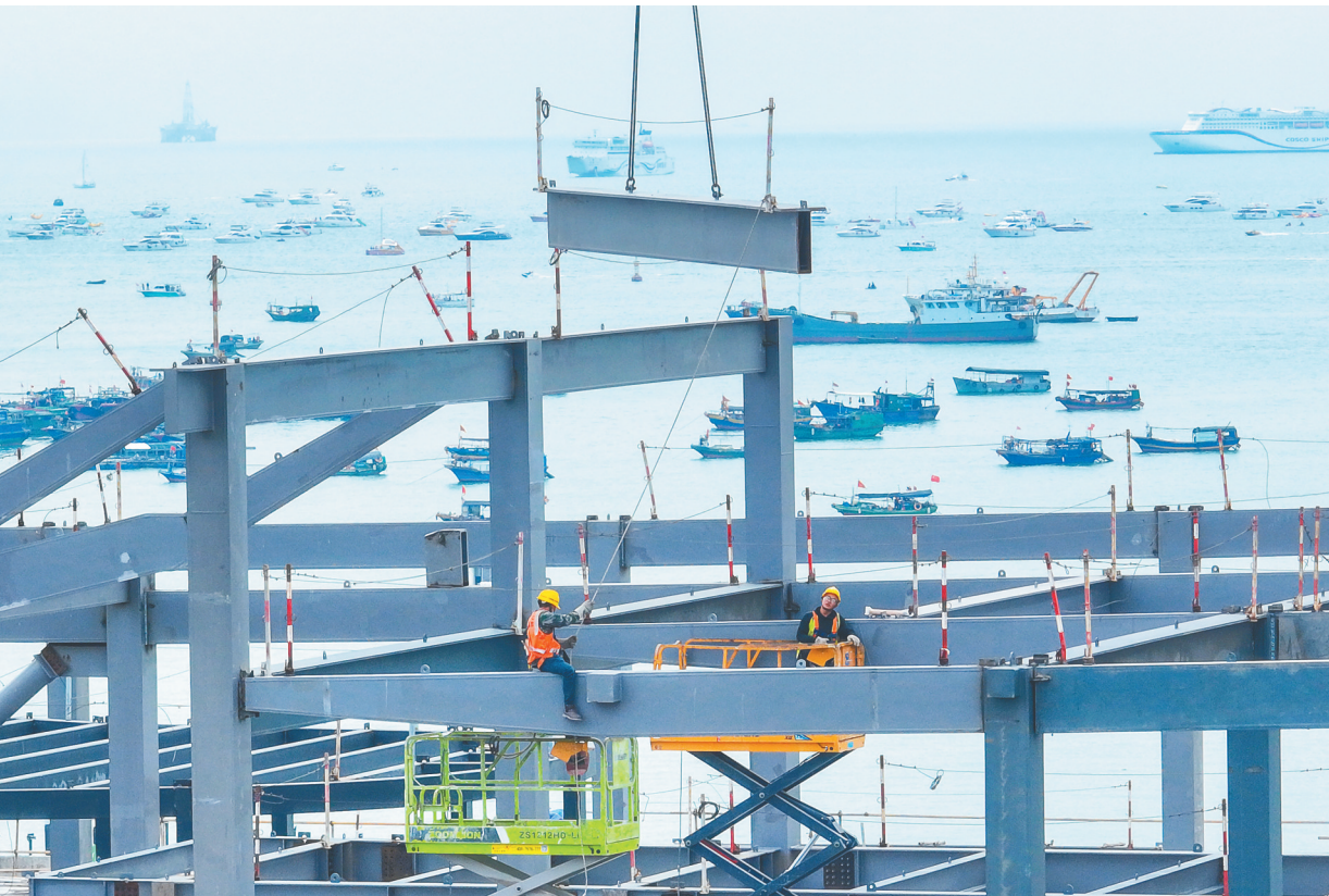
三亚合联中央商务区主体结构完工
