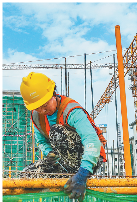
工作人员在加紧施工。本版图片均由本报记者 陈元才 摄
