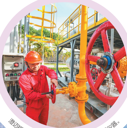
澄迈福山油田花场油气处理站,工作人员调试仪器。
