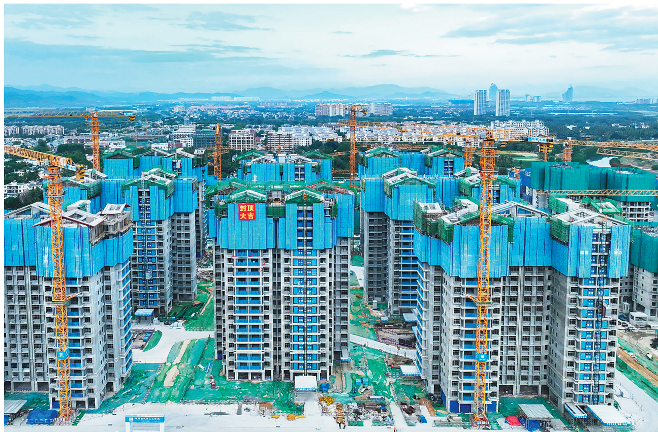
12月26日，俯瞰三亚市海棠湾林旺中安置区(一期)施工现场，3号地块已全部封顶。王将就 摄
