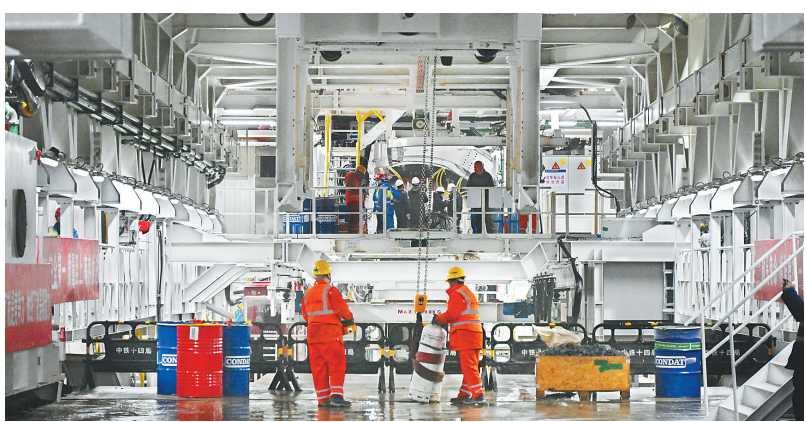
12月30日，由中国铁建四院设计、中铁十四局施工的青岛胶州湾第二隧道主线隧道开始盾构掘进，标志着我国建设规模最大、长度最长的海底道路隧道主体正式开启盾构穿海作业。青岛胶州湾第二隧道连接青岛主城区和国家级新区青岛西海岸新区，设计时速80公里。工程全长17.48公里。图为建设者在现场作业。新华社记者 李紫恒 摄
