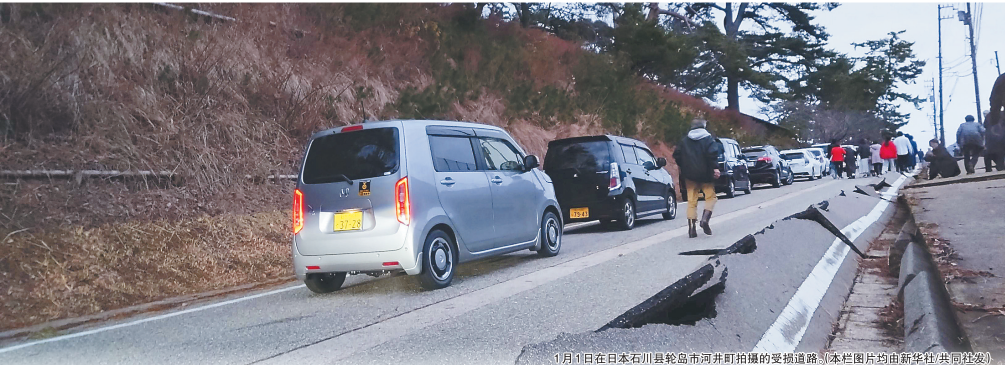
1月1日在日本石川县轮岛市河井町拍摄的受损道路。(本栏图片均由新华社/共同社发)
