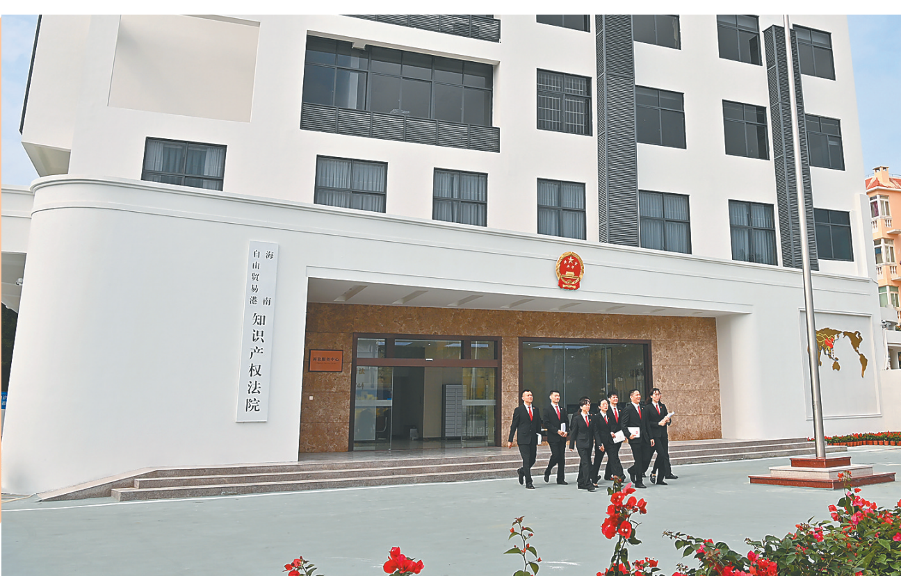
海南自由贸易港知识产权法院办公大楼。 黄叶华 摄
