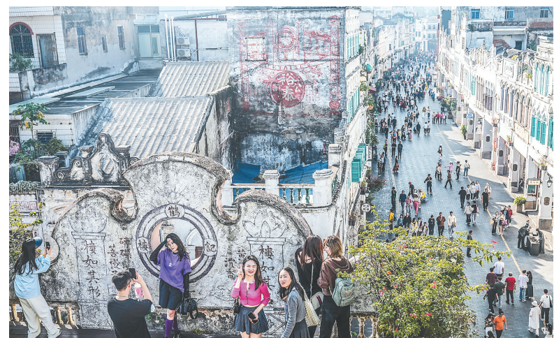
骑楼建筑立面修缮保护490栋，危房加固修缮55栋。随后，为保留老街原有风貌并提升其
