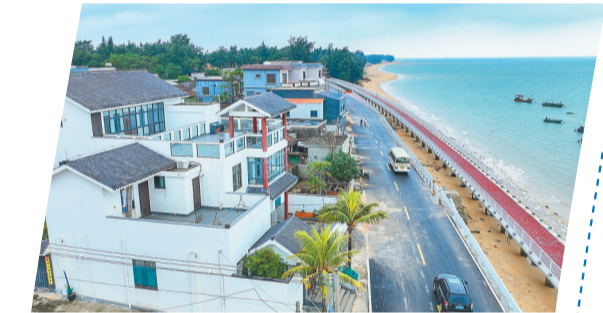
海南环岛旅游公路临高县龙豪村段。海南日报记者 陈元才 摄
