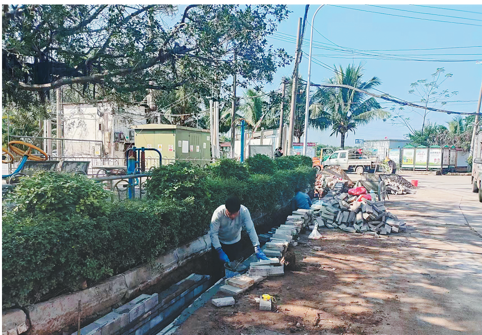
海口秀英区永庄村雨污分流改造工程现场。受访者供图
