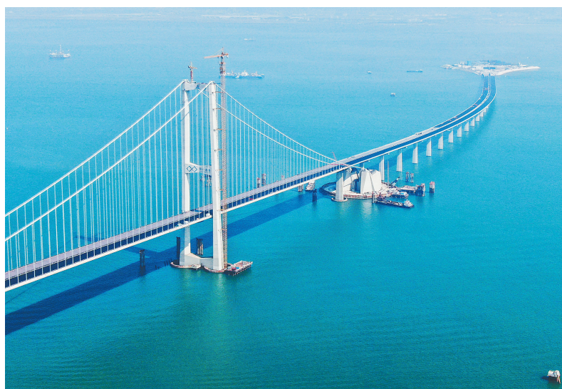
2023年11月28日，粤港澳大湾区超级工程深中通道主线正式贯通。图为深中通道伶仃洋大桥东塔及西人工岛。新华社记者 邓华 摄
