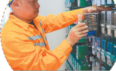
王笑冰在实训室查找电路故障。符祥陆 摄
