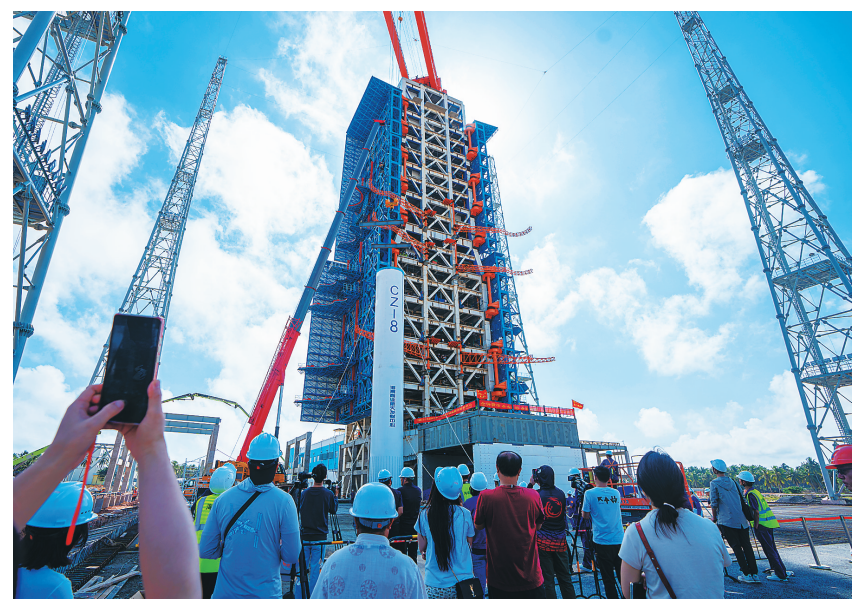
2月1日，海南国际商业发射中心在一号发射工位开展吊装训练。
