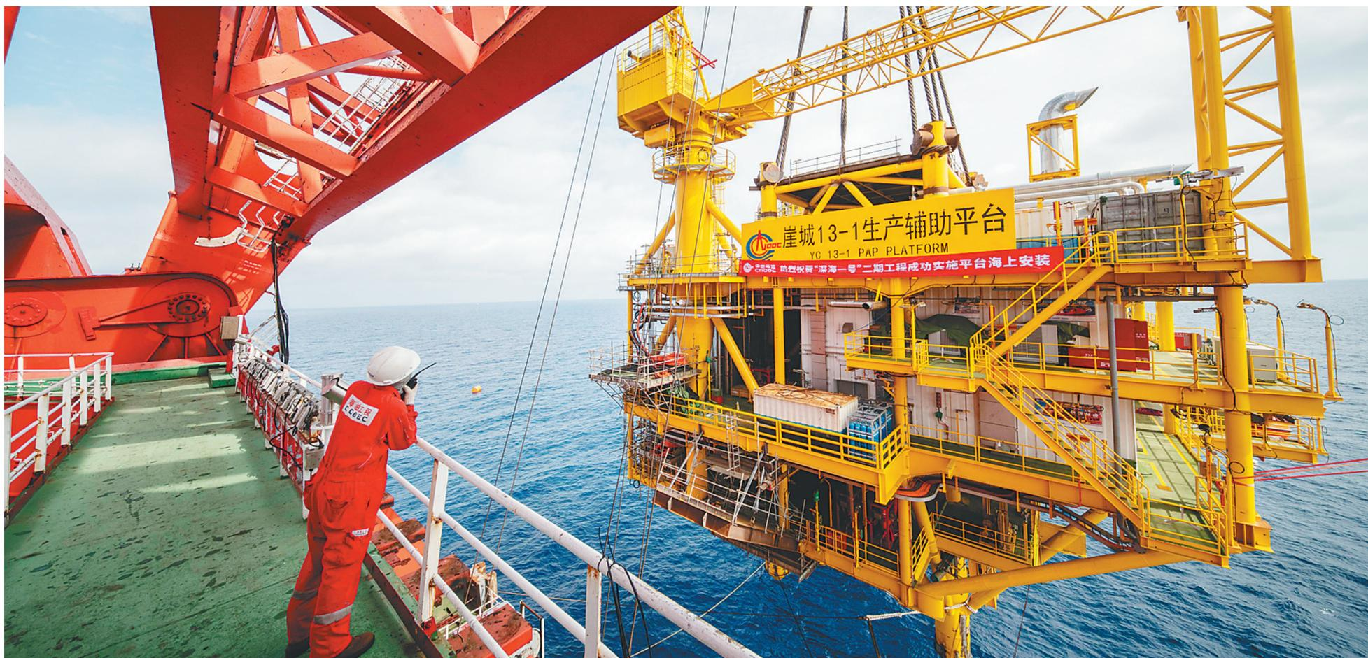
2月18日，作业队长指挥吊机手进行水上生产组块吊装。
