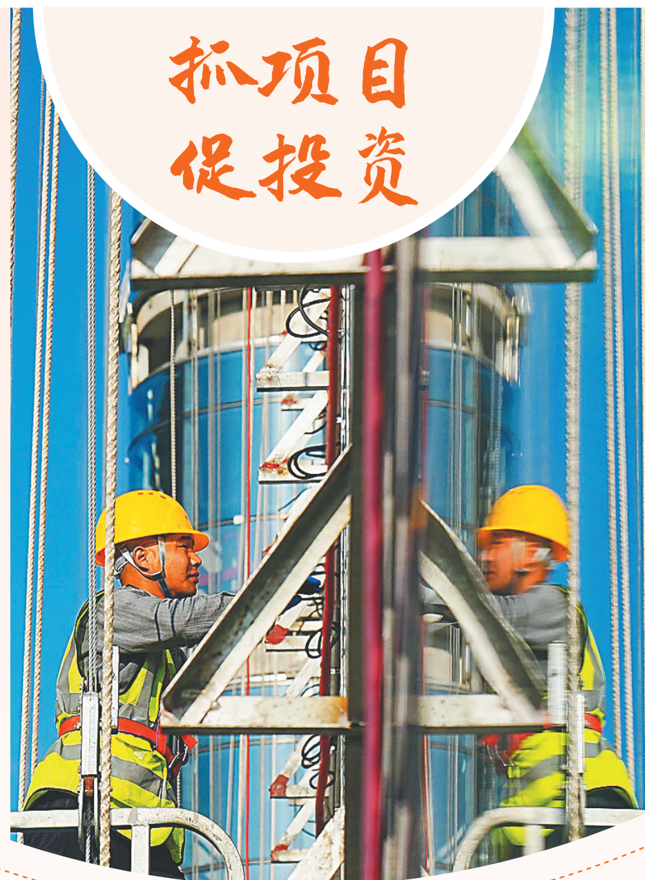
在三亚大悦城中心项目现场，工人进行外立面幕墙安装工作。本报记者 王程龙 摄
