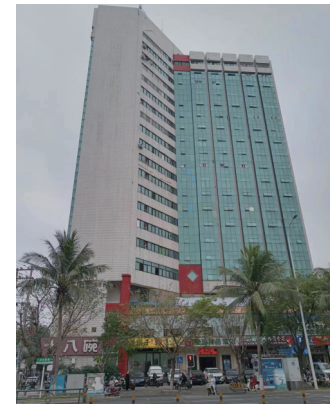
海瀛大厦实景图
