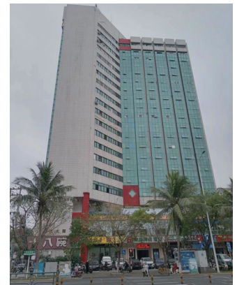
海瀛大厦实景图
