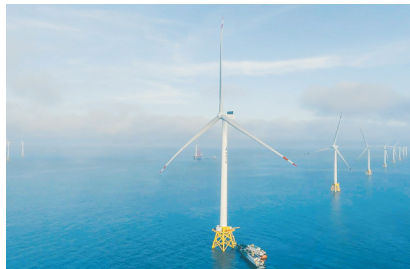
16兆瓦超大容量海上风电机组在三峡集团福建海上风电场并网发电。
