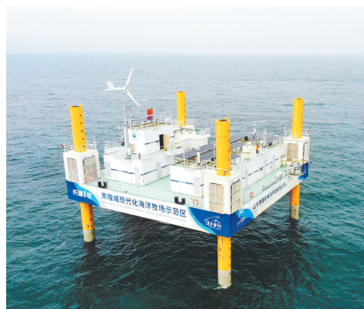
山东长岛综合试验区南隍城国家级海洋牧场示范区海上平台。
