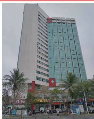
海瀛大厦实景图
