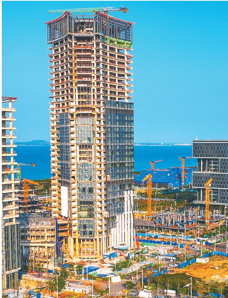
近日，在中国石化自贸大厦项目现场，工人正在进行幕墙安装、砌体等施工，项目整体形象已经露出真容，目前，项目总体进度完成65%。图为中国石化自贸大厦项目现场。
