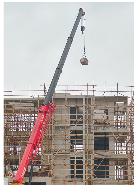
项目工地正在施工。
